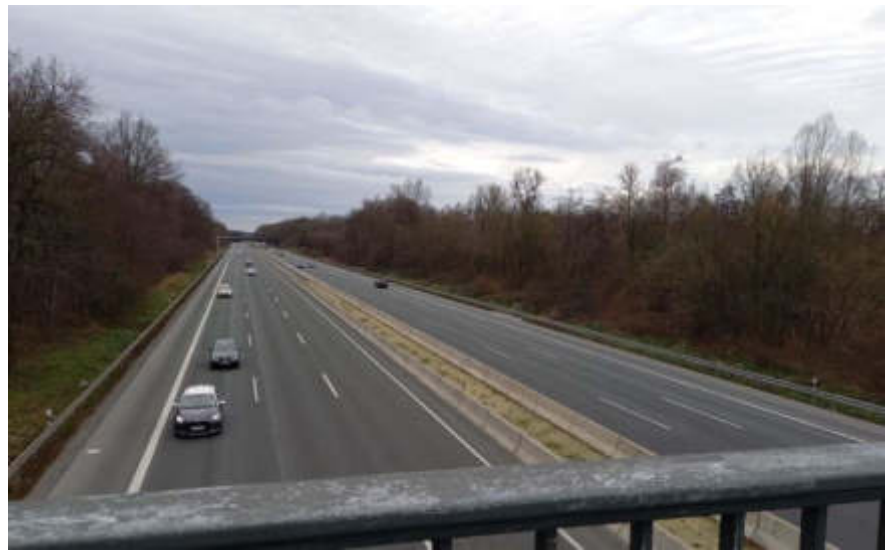
Autobahn A3 in Solingen in Blickrichtung Köln: Manchmal leerer als mancher denkt Foto: Claudia Roth
